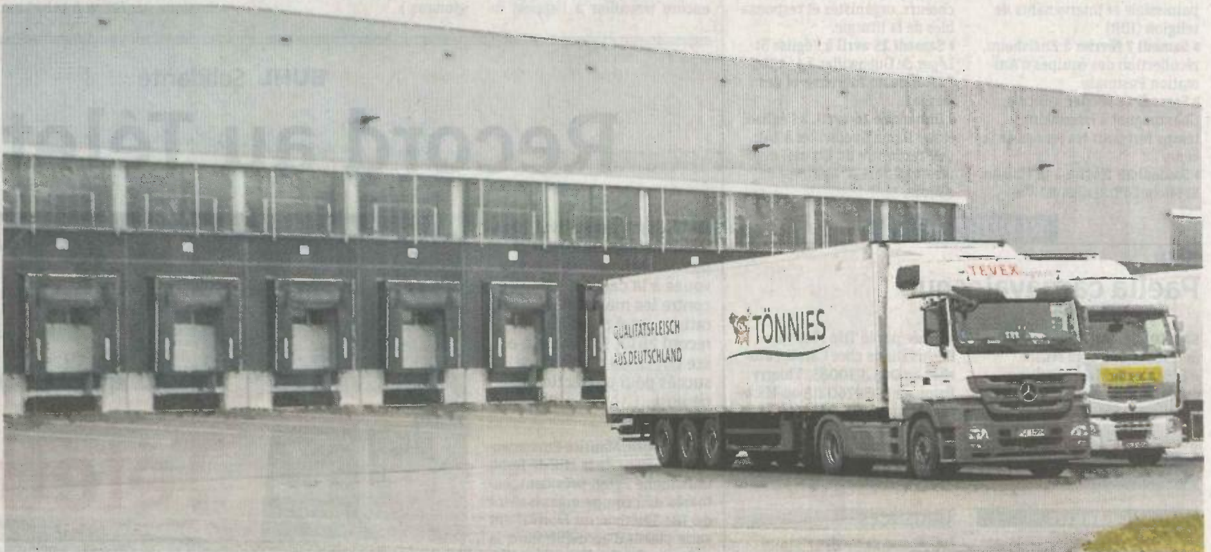
Le centre logistique de Lidl, une des grosses entreprises installées de l'autre côté du Rhin dans le GewerbePark Breisgau. PHOTOS DNA
